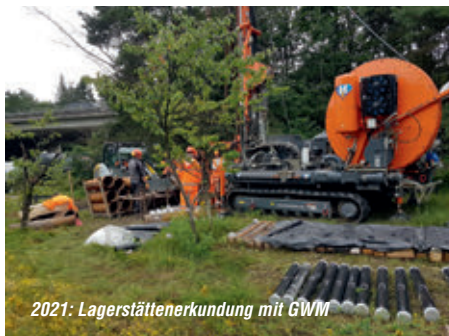
2022: Erkundungsbohrung mit Ausbau zur GWM
